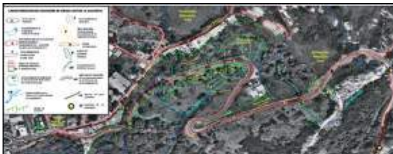
Deslizamiento de la Vuelta de Lola. Fuente: Google Satélite
