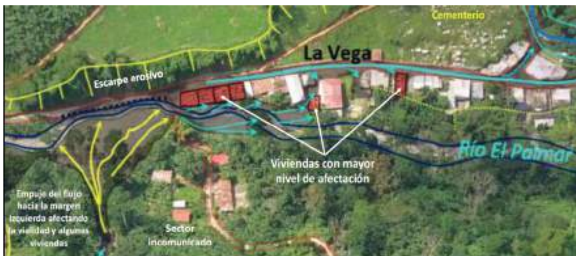
Viviendas y flujo torrencial en los sitios críticos. Fuente: Fotografía tomada con el Drone 28/4/23.
