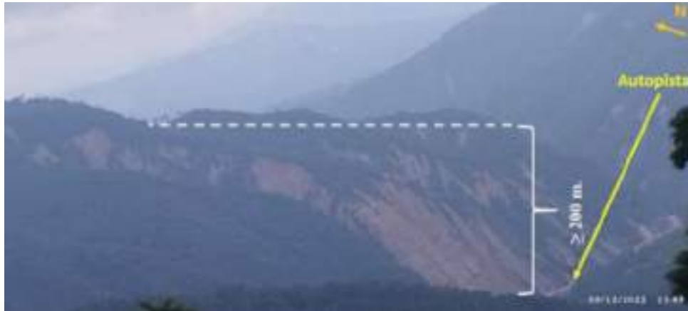
Procesos geomorfológicos, mega deslizamiento (túneles) Se presenta una vista de un mega deslizamiento que se inicia a nivel de la carretera vieja y termina en la autopista. Fuente: Ayala (2013)
