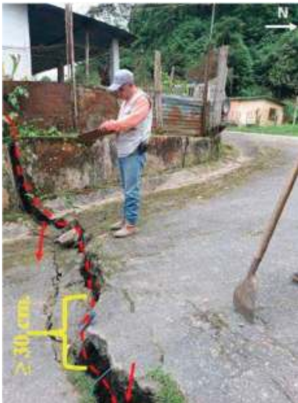
Falla de borde, evidencias en la carretera vieja (La Palmita). Fuente: INGEOMIN (2022)
