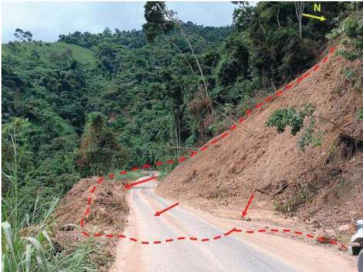
Procesos geomorfológicos, deslizamiento de lodo. Fuente: INGEOMIN (2022)
