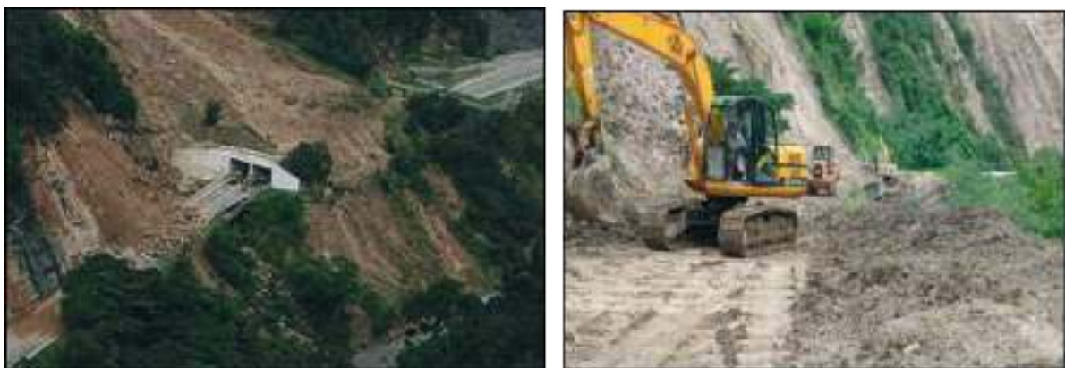
Procesos geomorfológicos, falso túnel. Fuente: INGEOMIN (2022)
