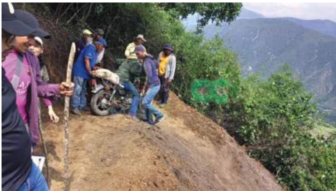
Fotografías de la trocha. Vía alterna. Fuente: Fotografías tomadas en campo.
