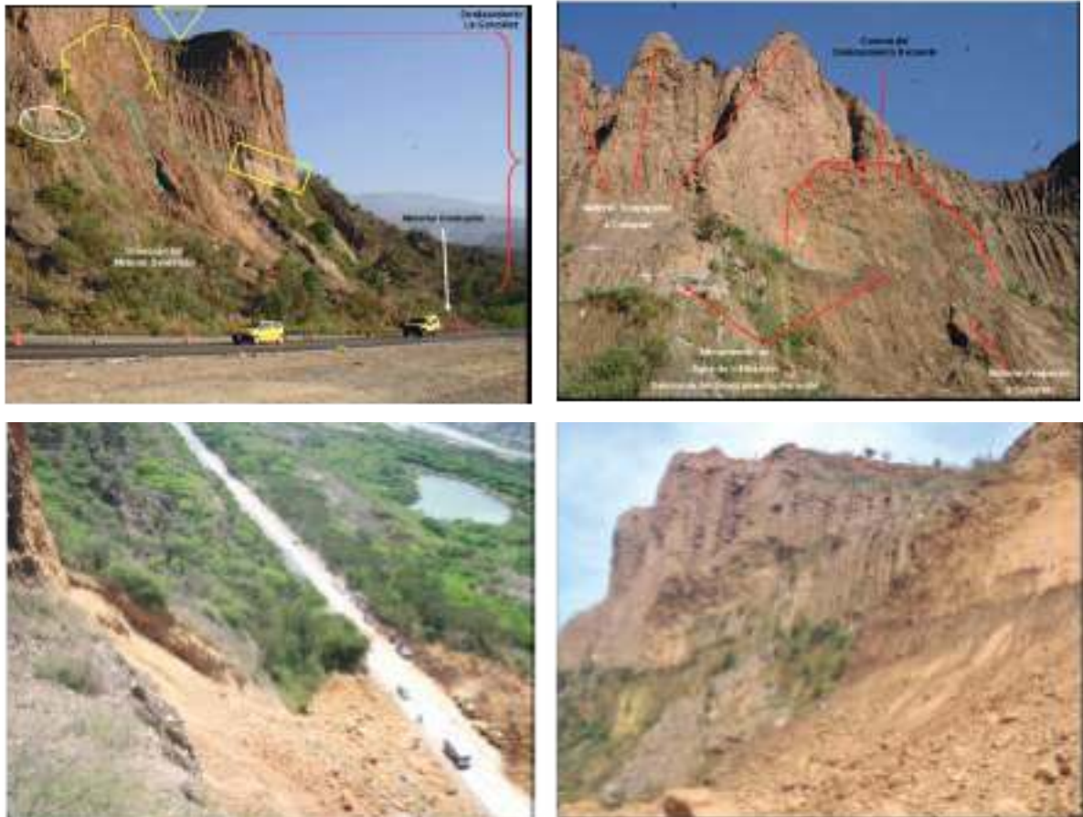
Fotos, deslizamiento de La González. Fuente: Fotografías tomadas en campo 30/4/23
